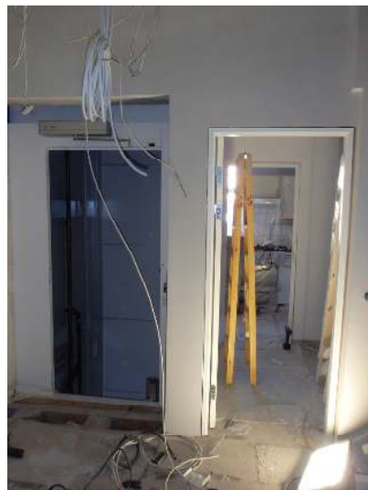
Skakt til handicaplift under ombygningen
