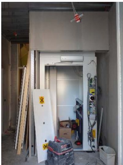
Skakt til handicaplift under ombygningen
