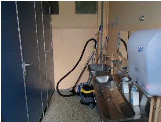
Fællestoilet før og under ombygning til handikaptoilet
