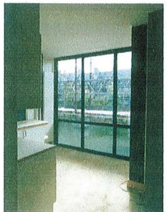
Fotos fra Karré 24 under byggeriet.
