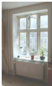
Radiatorer placeret under hhv. 2- og 3-fags Dannebrogsvinduer
