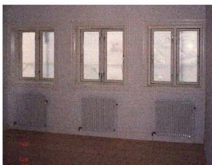
Skjult rørføring, trukket under nye gulve.
