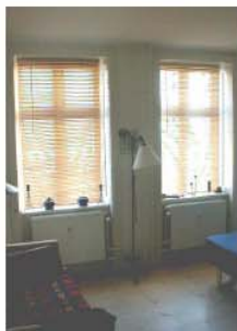
Radiatorer placeret under hhv. 2- og 3-fags Dannebrogsvinduer
