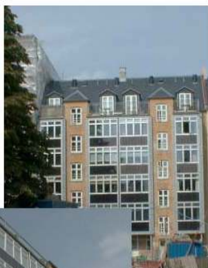
Solceller på gårdfacaden
