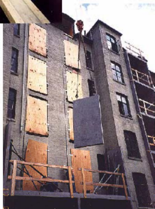
Udestuernes etagehøje betonelementer monteres på gårdfacaden.
