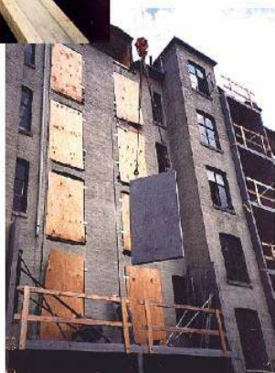
Udestuernes etagehøje betonelementer monteres på gårdfacaden.
