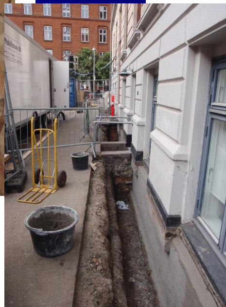
Berapning af udv. kældervægge før ilægning af omfangsdræn
