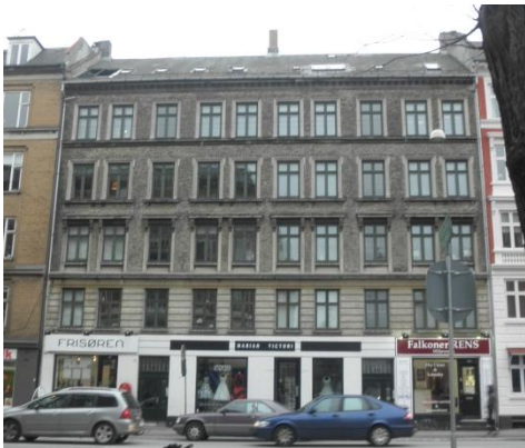
Gade- og gårdfacade før istandsættelsen
