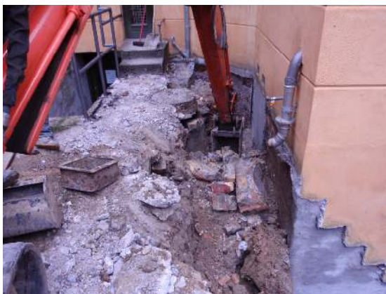
Nedrivning af trappe
