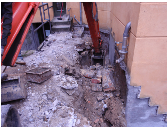
Nedrivning af trappe
