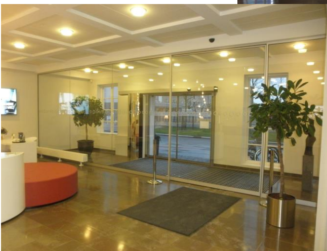
Nyt vindfang med skydedør og nyt varmetæppe.
